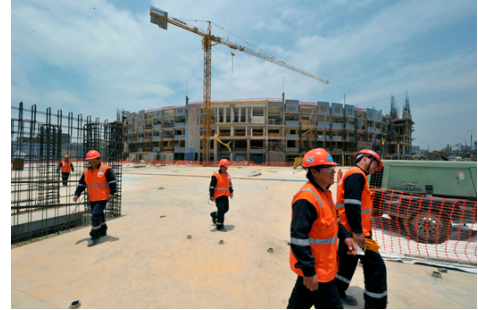
Obreros de la construcción remodelando el Estadio Nacional en Lima, Perú. El crecimiento en América Latina se ha mantenido relativamente sólido hasta el momento (Foto: Chris Bouroncle/Newscom)
