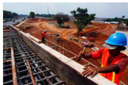
Carretera en construcción en Yakarta, Indonesia. El nuevo programa de trabajo del FMI apunta a respaldar la cooperación y el crecimiento mundial. (Foto: Crack Palinggi/Newscom)
