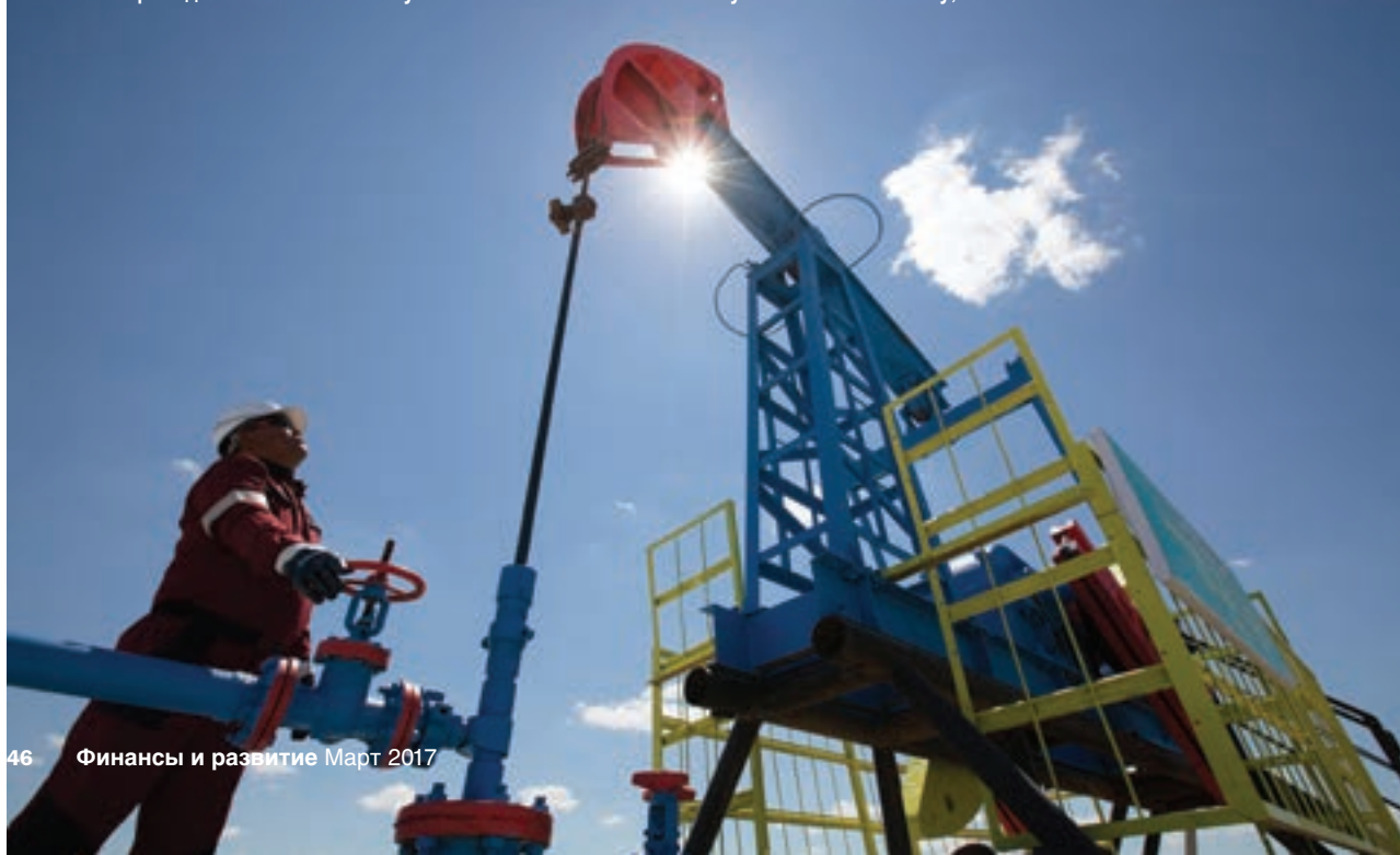
Работник проводит техническое обслуживание скважинной насосной установки в Аккыстау, Казахстан.
