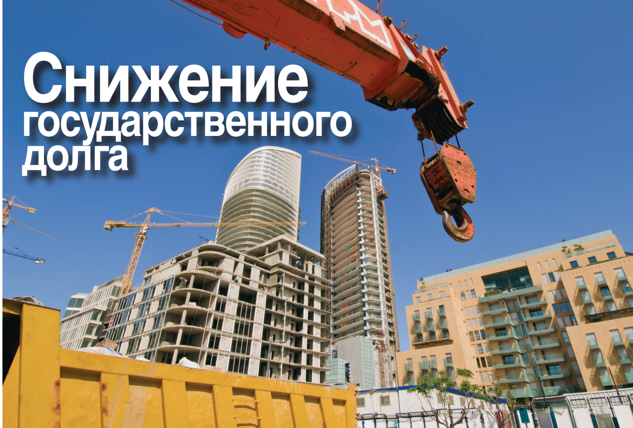
Строительство в Бейруте.
