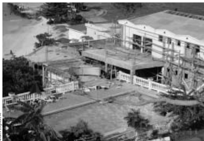
Reconstrucción de un hotel en Saint George's, Granada, tras la devastación del huracán Iván.
