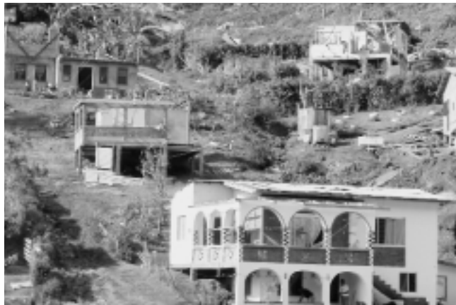
Vue de Saint-Georges, à la Grenade. Environ 90 % des logements de l'île ont été endommagés ou détruits par l'ouragan Ivan.
