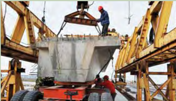
Un proyecto de construcción en Jiangsu, China.
