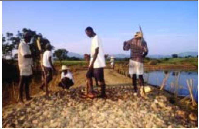
Construcción de un lago artificial en Haití.
