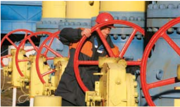
Белорусский рабочий на трубопроводе «Ямал-Европа».
