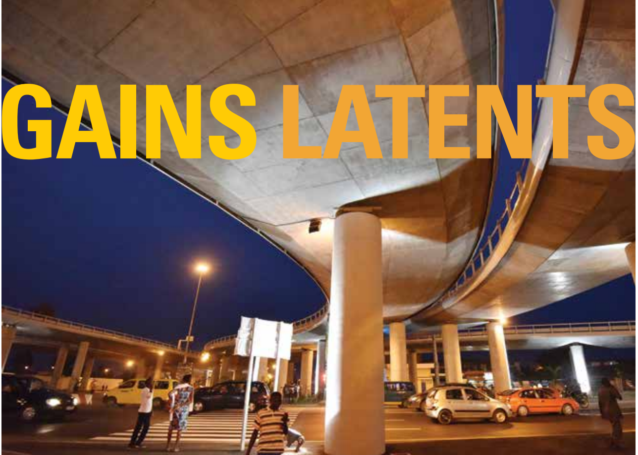
Le pont Henri-Konan-Bédié, issu d'un partenariat public-privé, relie le Nord et le Sud d'Abidjan, capitale économique de la Côte d'Ivoire.
