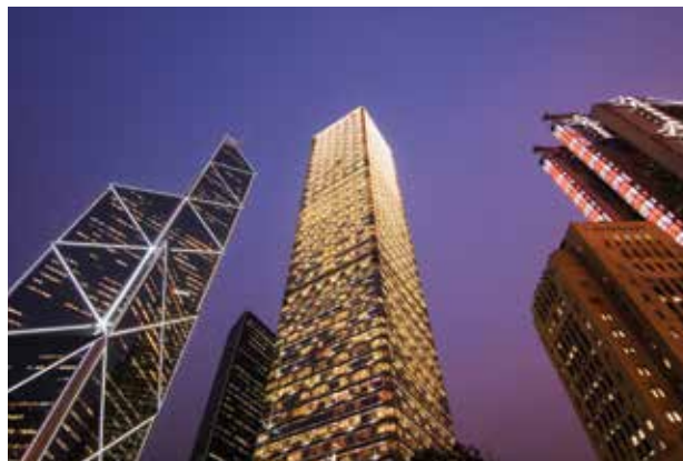
Trois gratte-ciel bancaires dans la RAS de Hong Kong.
