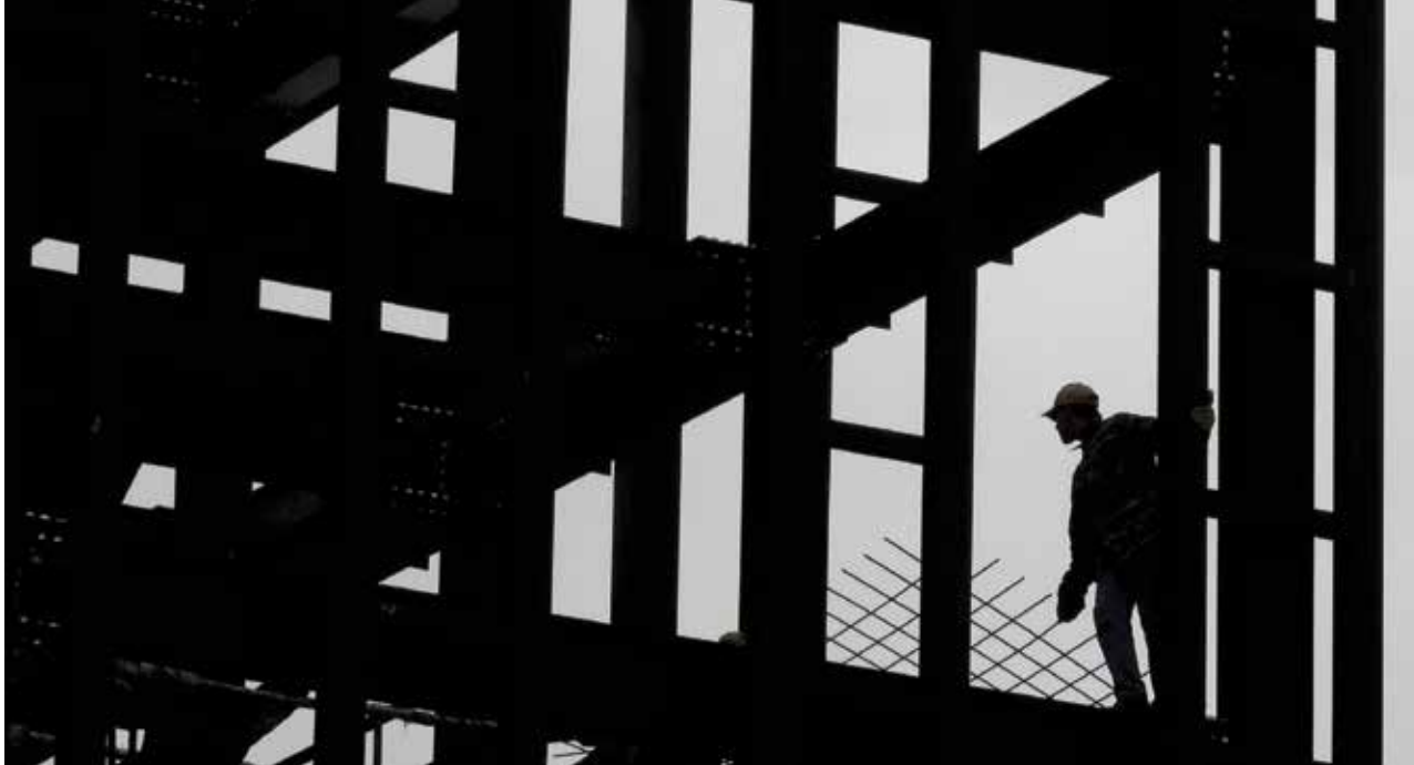
Un ouvrier sur un chantier à Athènes.
