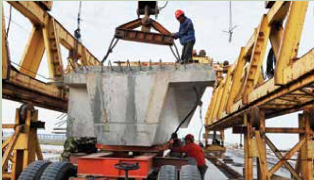
Projet de construction dans la province du Jiangsu, en Chine.
