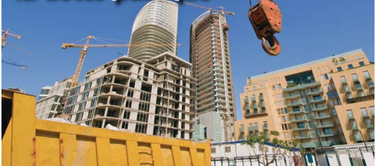
Chantier à Beyrouth.
