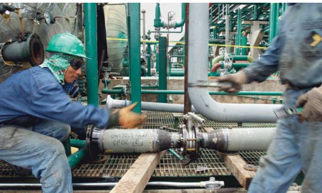
Modernisation d'une installation de production de pétrole en Équateur.
