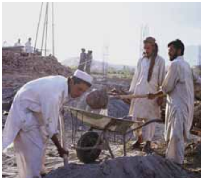
En las afueras de Kabul, Afganistán, avanza la reconstrucción.
