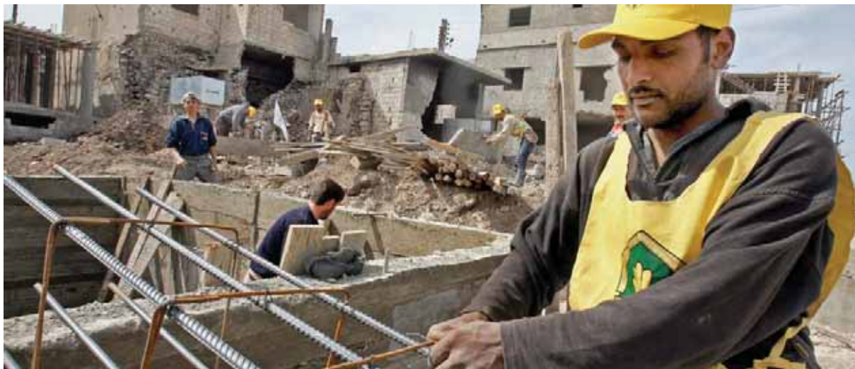
Восстановительные работы в постконфликтном Ливане.
