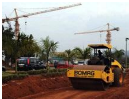
Construction d'une route à Kigali, au Rwanda : le manque d'infrastructures constitue le principal obstacle au commerce intra-africain (photo: Simon Maina/AFP)
